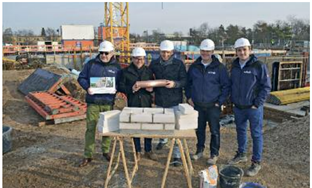
Klaus Dörner (2.v.l.) und Willi Kuntz (3.v.l.) freuen sich gemeinsam mit einer Delegation des Projektentwicklers Vollack über die Grundsteinlegung.
